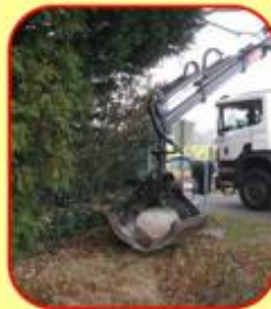
De vervangende steen wordt geplaatst.
